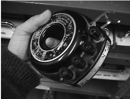
Transformador de corriente típico
