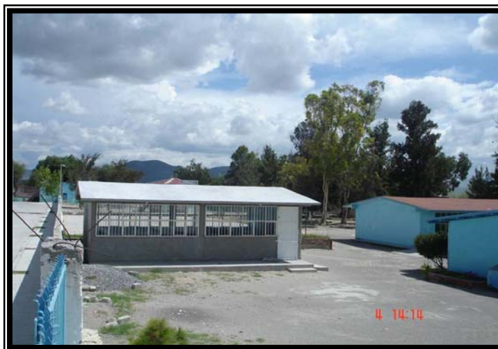
SALA DE CÓMPUTO DE LA ESCUELA PRIMARIA
